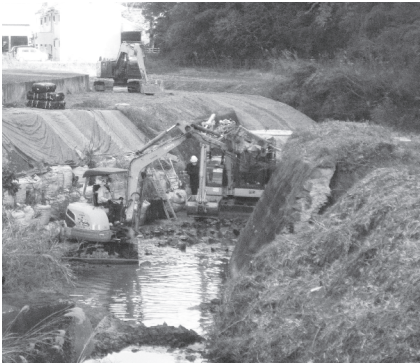
武雄川現在進む堰下流工事
