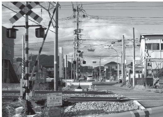
沖永踏切り、ジャリの部分が一時拡大跡
