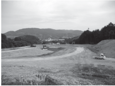
② 嬉野みゆき公園球技場（造成中）
