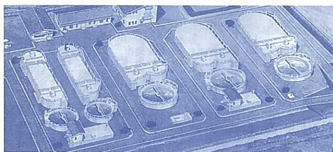
30年後の全体予想図で、今回西側の1系列のみが完成 し、今後配管をH22年までに整備するが、現在1,300人 と農排規模しかない。
