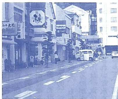
下水配管を付設中の温泉新道 今後、蓬萊町→宮野町→中町へ
