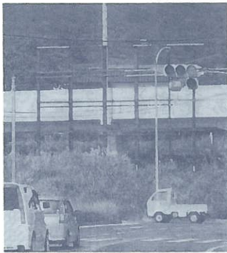
県が規制撤去の堂島交差点
