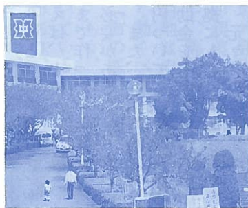
耐震補強と教室リニューアル 1 億4,700万円 (北方町)
