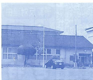
木造校舎を解体し、鉄筋2階建 5億7,501万円
